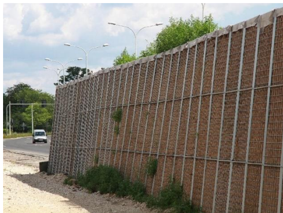
Rysunek 13 Przykład konstrukcji ekranu ziemnego
